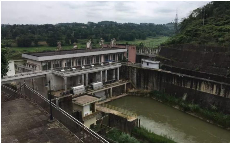
图 3-1 工程河段上游王二溪电站
