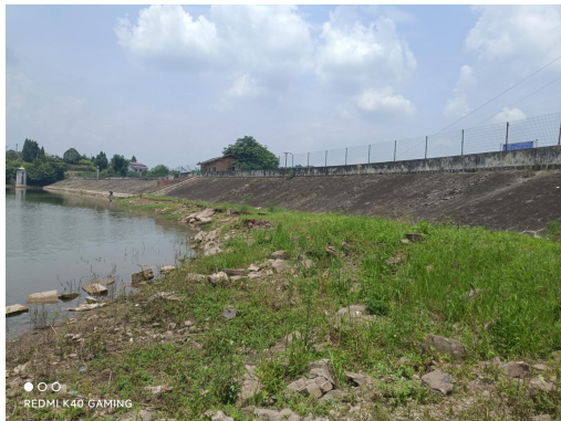
图 3-7 上游护坡未护至死水位
