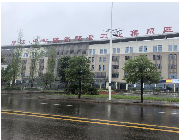
西北侧雁江临空制造配套产业园办公楼
