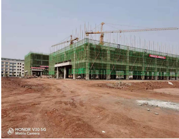
本项目建设现状
