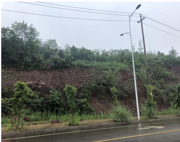
项目西侧山坡
